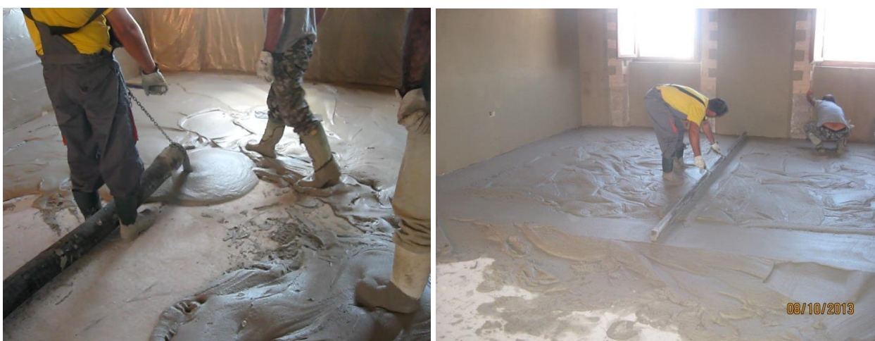
Figura 2. Alcune fasi di realizzazione di un massetto alleggerito con perlite espansa, formulato con un mix a base di anidrite sintetica. Da notare che il materiale è messo in opera mediante pompaggio con betonpompa, secondo la più "classica" tecnologia del calcestruzzo preconfezionato.
